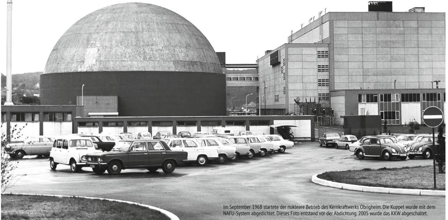
Im September 1968 startete der nukleare Betrieb des Kernkraftwerks Obrigheim. Die Kuppel wurde mit dem NAFU-System abgedichtet. Dieses Foto entstand vor der Abdichtung. 2005 wurde das KKW abgeschaltet.
