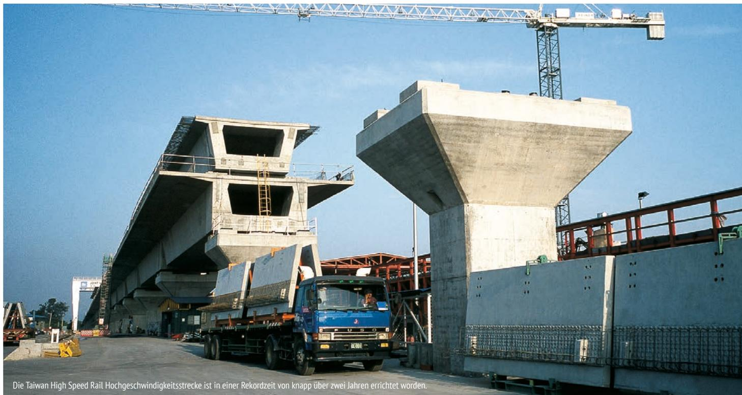
Die Taiwan High Speed Rail Hochgeschwindigkeitsstrecke ist in einer Rekordzeit von knapp über zwei Jahren errichtet worden.
