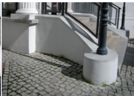
Dauerhafte Sockelinstandsetzung auch bei denkmalgeschützten Gebäuden
