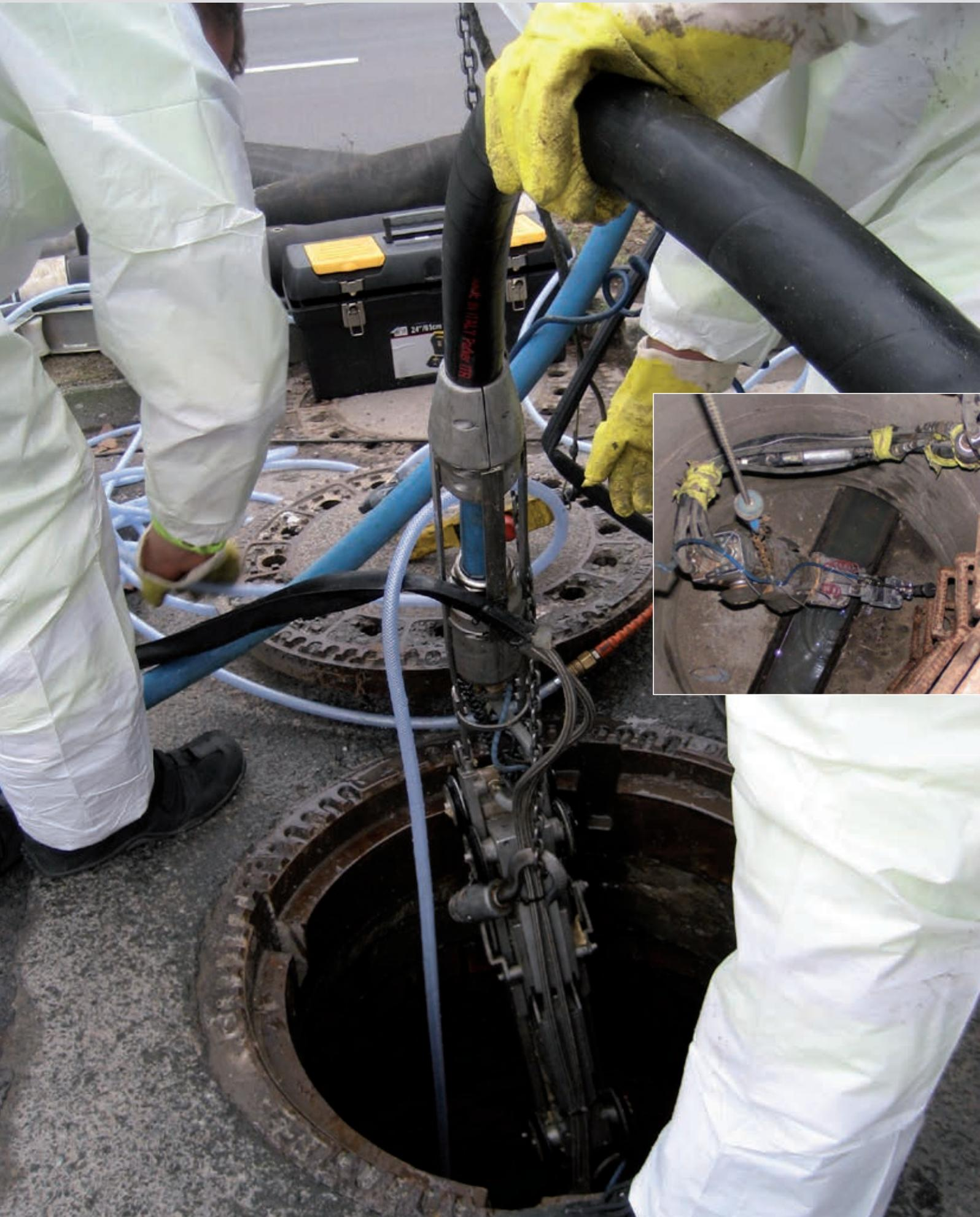
Bei der Sanierung von nicht begehbaren Abwasserleitungen können neben der Reparatur mit Kurzlinersystemen auch Robotersysteme zum Einsatz kommen. Mit Hilfe der Robotertechnik können Schadstellen mit high-performance Reaktionsharzsyste-men von ombran repariert werden.
