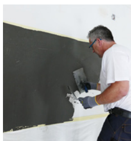
Schritt 2: Applikation der ersten Lage Emcefix-Spachtel F lang, Farbe anthrazit.
