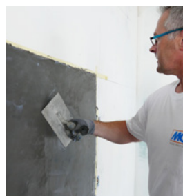
Schritt 4: Mit der Imprägnierung MC-Color Proof pure wird die Marmorierung hergestellt.
