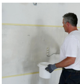
Schritt 1: Abkleben und je nach Untergrund bei Bedarf Grundieren der Fläche.
