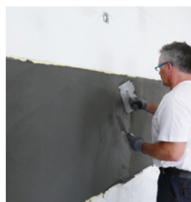
Schritt 3: Am nächsten Tag wird die zweite Lage des Spachtels aufgetragen und anschließend geglättet.
