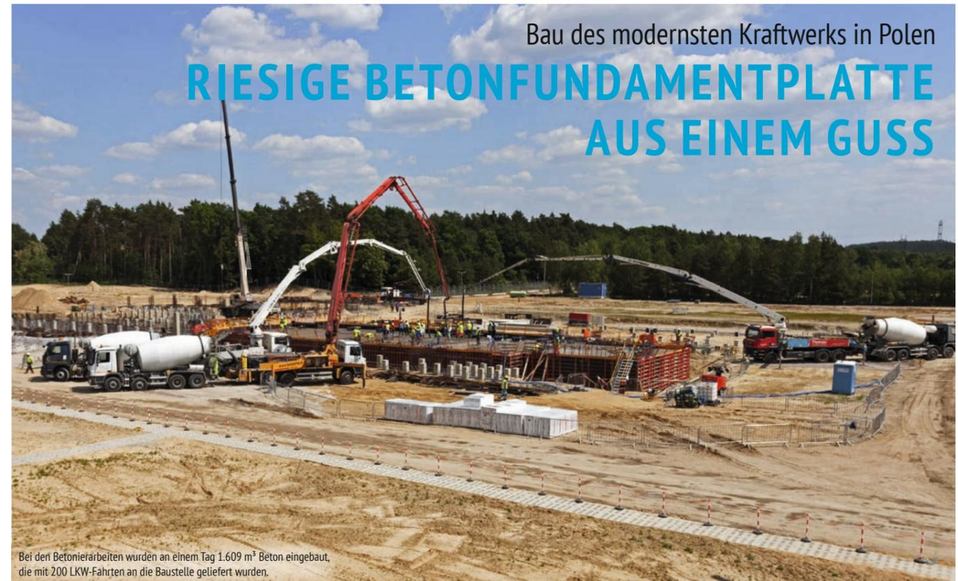
Bei den Betonierarbeiten wurden an einem Tag 1.609 m<sup>3</sup> Beton eingebaut, die mit 200 LKW-Fahrten an die Baustelle geliefert wurden.
