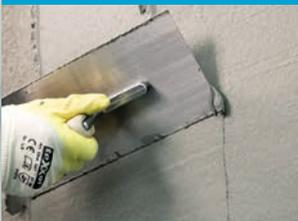
Auch unter schwierigen Witterungsbedingungen, zum Beispiel bei starkem Wind, ist Nafufill R3 FM die perfekte Lösung für die Egalisierung von Betonoberflächen. Der Hochleistungs-Feinmörtel ist **nachbehandlungsfrei** gemäß VGB-Richtlinie R 612 U (2010). Dadurch reduzieren Sie insbesondere bei der
