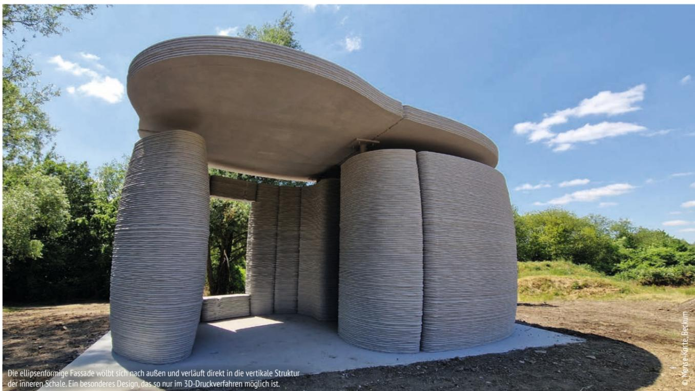
Die ellipsenförmige Fassade wölbt sich nach außen und verläuft direkt in die vertikale Struktur der inneren Schale. Ein besonderes Design, das so nur im 3D-Druckverfahren möglich ist.
